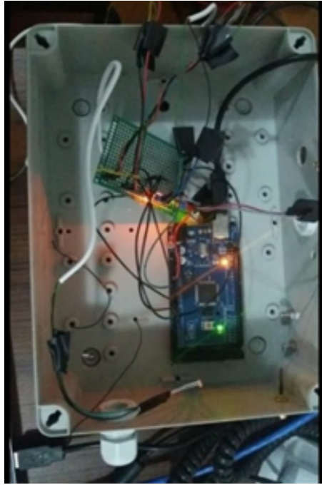
Figura. 1 – Montagem Cx. Sensores
